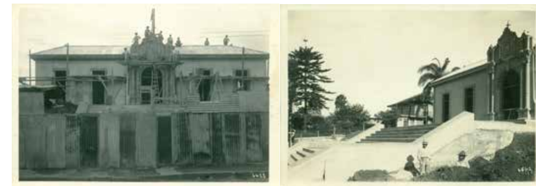
Manuel Gómez Miralles Construcción de la actual Casa Amarilla Aproximadamente 1916 Cortesía de la Biblioteca Teodorico Quirós
