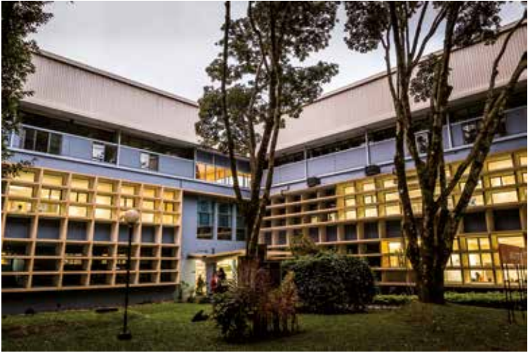
Edificio donde se ubicó la Facultad de Ingeniería hasta el año 2017
