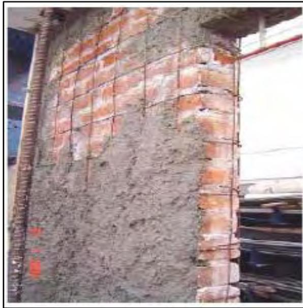
Figura 6-1. Uso de malla de alambre electrosoldada para fines de rehabilitación sísmica
