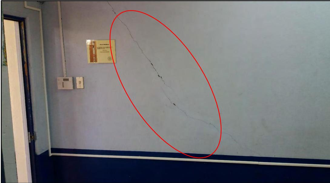
Figura 4-3. Grieta por tracción diagonal en muro del primer piso. Edificio A. Eje 2. Sentido Norte-Sur
