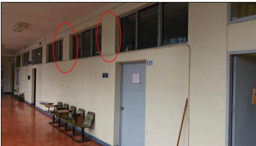
Figura 4-14. Pilares reforzados debido a falla por efecto de "columna corta" en primer piso. Edificio A. Eje D. Sentido Oeste-Este
