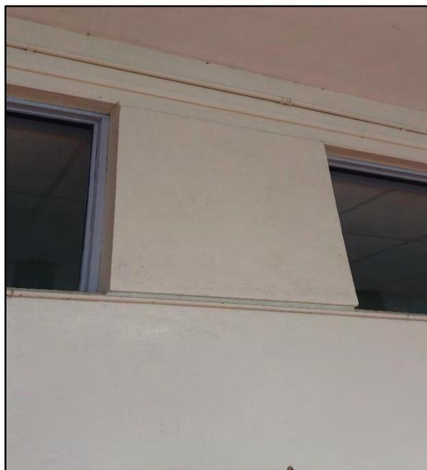
Figura 4-15. Ejemplo de pilar reforzado debido a falla por efecto de "columna corta" en primer piso. Edificio A. Eje D. Sentido Oeste-Este
