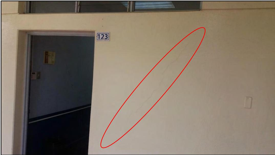
Figura 4-11. Grieta por tracción diagonal en muro del primer piso. Edificio A. Eje D. Sentido Oeste-Este
