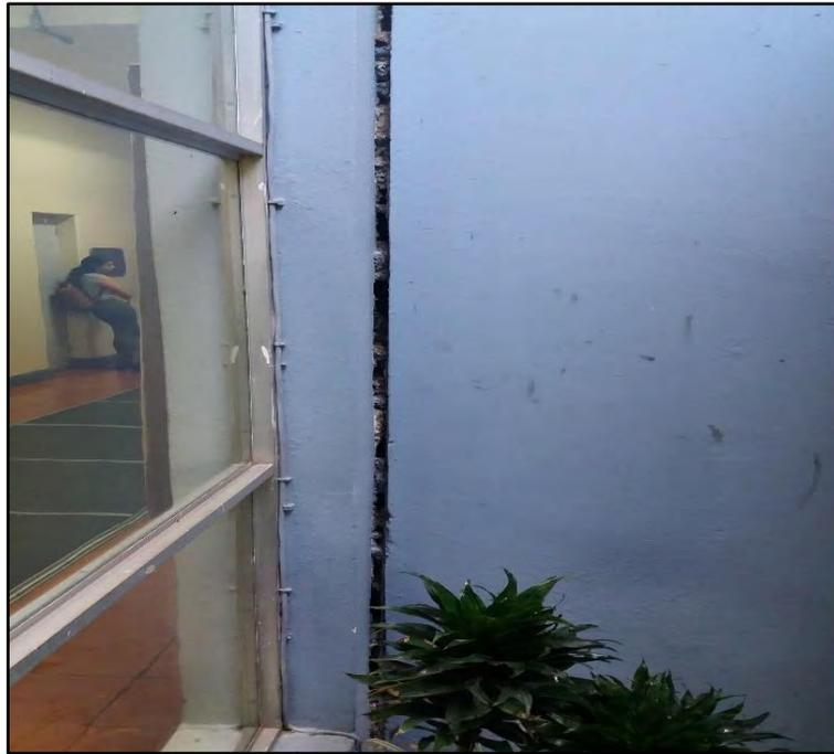
Figura 3-7. Junta de construcción que separa los edificios A y B de la facultad de Ingeniería
