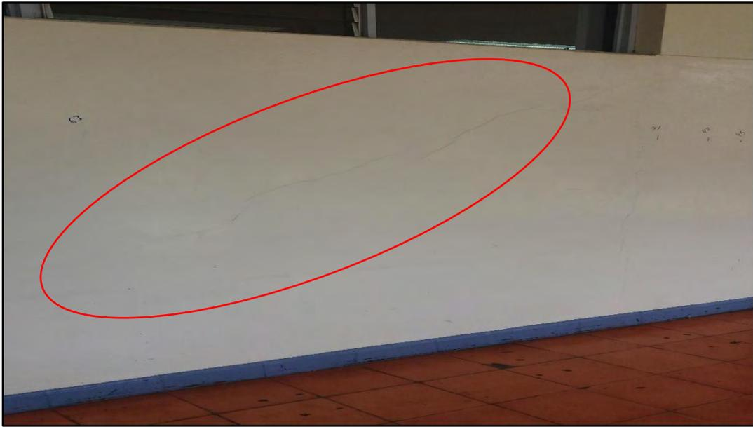
Figura 4-9. Grieta por tracción diagonal en muro del primer piso. Edificio A. Eje D. Sentido Oeste-Este
