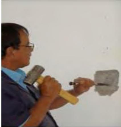
Figura 3-38. Procedimiento de realización de picas en el concreto
