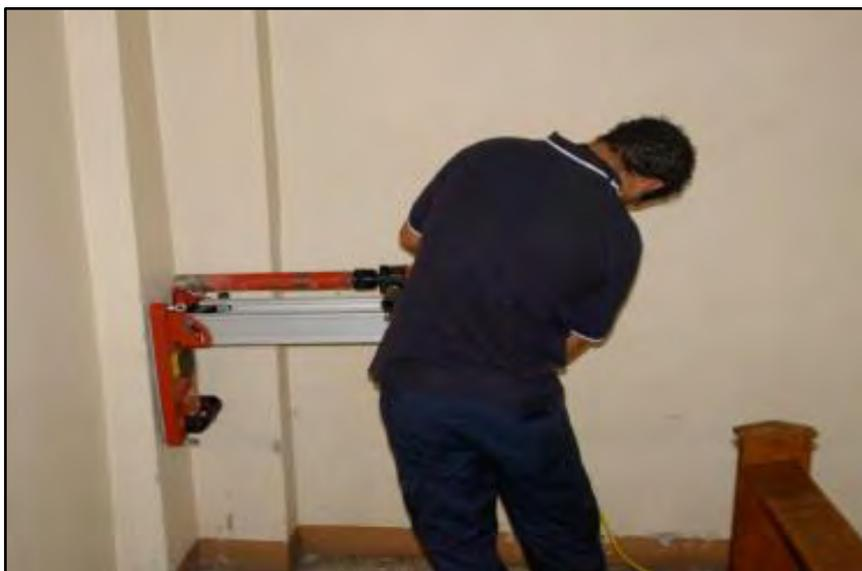
Figura 3-33. Procedimiento de extracción de núcleos de concreto
