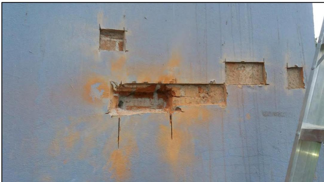
Figura 3-30. Extracción de ladrillo en pared externa del edificio de la Facultad de Ingeniería
