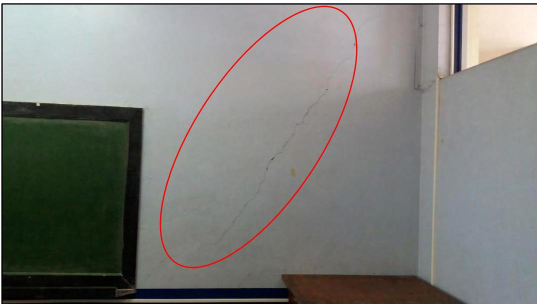
Figura 4-8. Grietas por tracción diagonal en muro del primer piso. Edificio A. Eje 2. Sentido Norte-Sur
