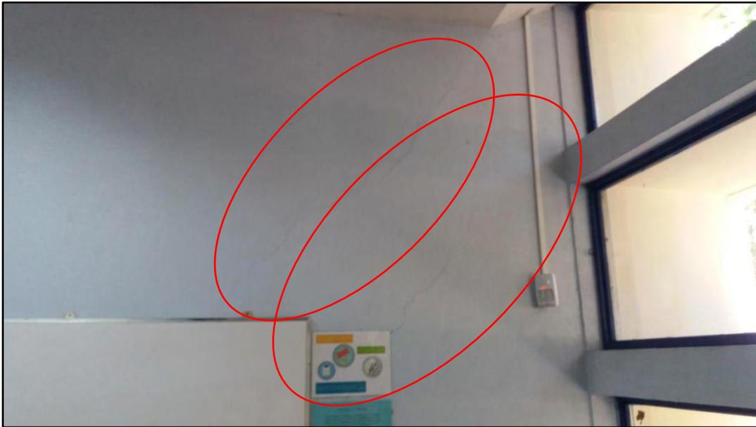
Figura 4-7. Grietas por tracción diagonal en muro del primer piso. Edificio A. Eje 2. Sentido Norte-Sur
