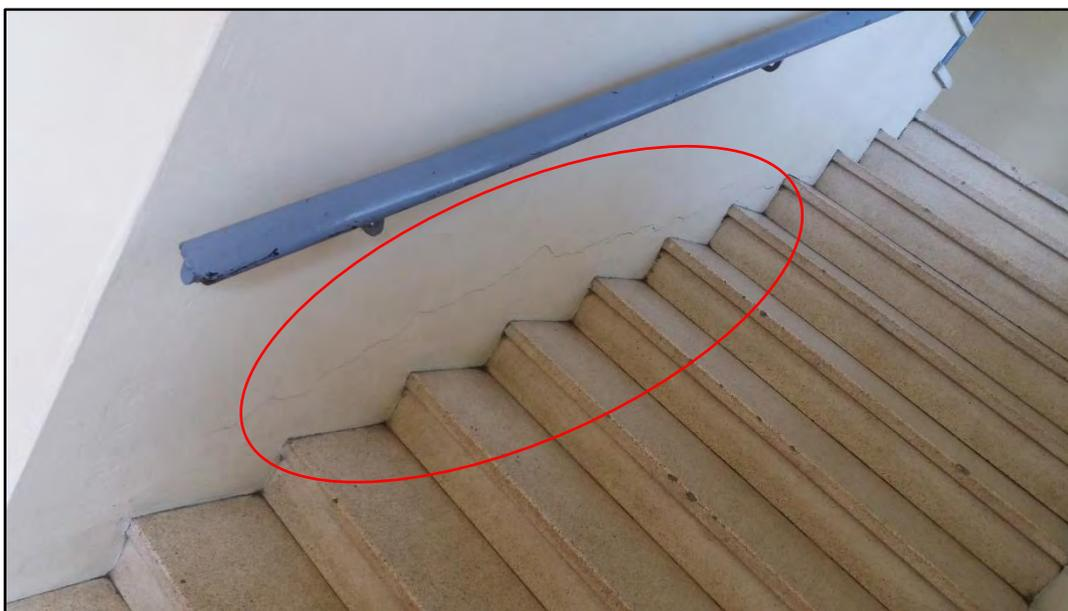
Figura 4-13. Grieta diagonal en muro de escaleras del primer piso. Edificio A. Sentido Oeste-Este
