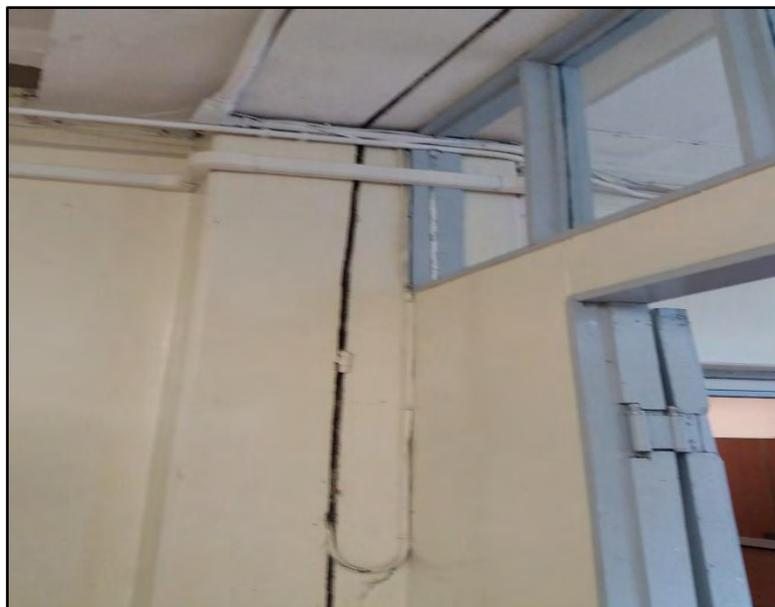
Figura 4-19. Junta de construcción entre Edificio A y edificio de laboratorios. Nivel de Sótano
