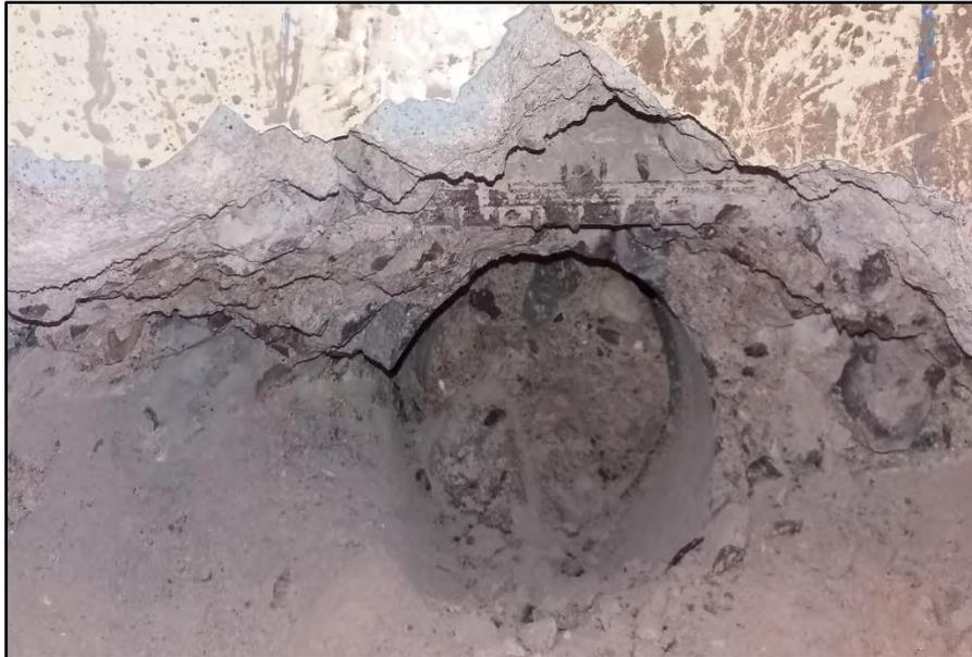
Figura 3-39. Acero de refuerzo expuesto con picas en concreto.
